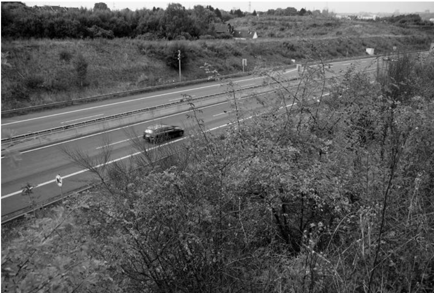
Abb. 3: Aus Nassansaat hervorgegangene Gehölzansaat nach sechs Jahren mit Entwicklung in Richtung eines bodensauren Laubgebüsches (B 236n, Dortmund). Foto: Bender GmbH & Co. KG
