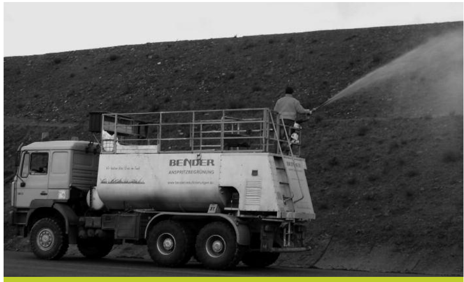
Abb. 1: Nassansaat mit Gehölzsaatgut auf Verkehrswegeböschung (B 236n, Dortmund)
